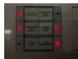
Lichtschalter an der Säule hinter der Theke
